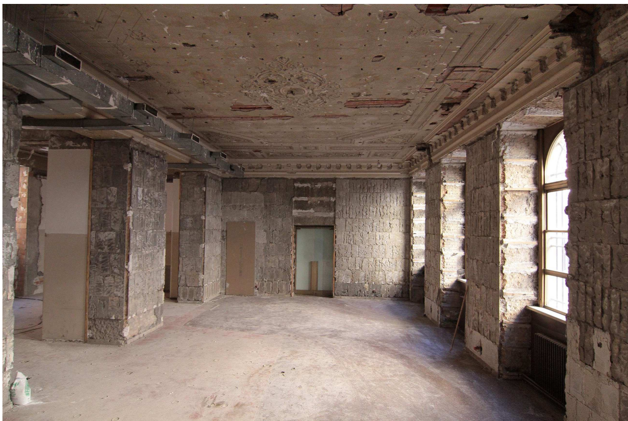
Il salone di piano terra come si presenta attualmente (tranne il soffitto che è stato già oggetto di restauro)
