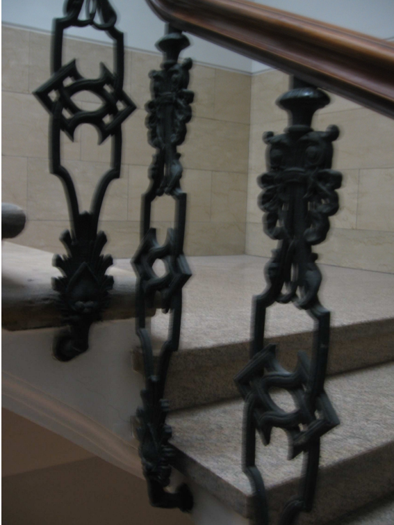
Punto di raccordo attuale tra gradini in granito e in travertino
