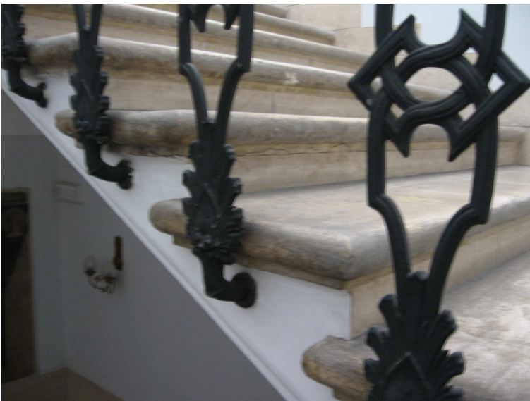
Gradini e sottogradi in travertino esistenti. I nuovi andranno eseguiti con la stessa tipologia.
